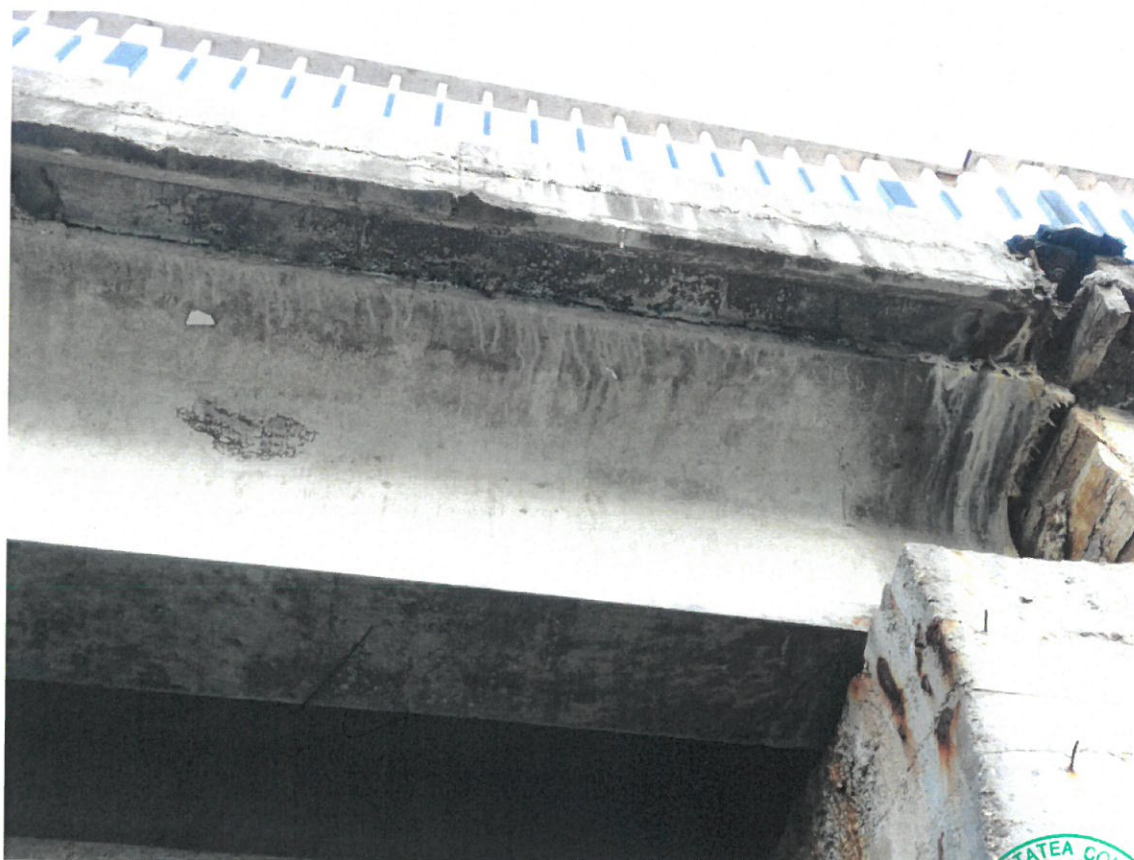
Foto nr. 1 - Armături fără strat de acoperire
