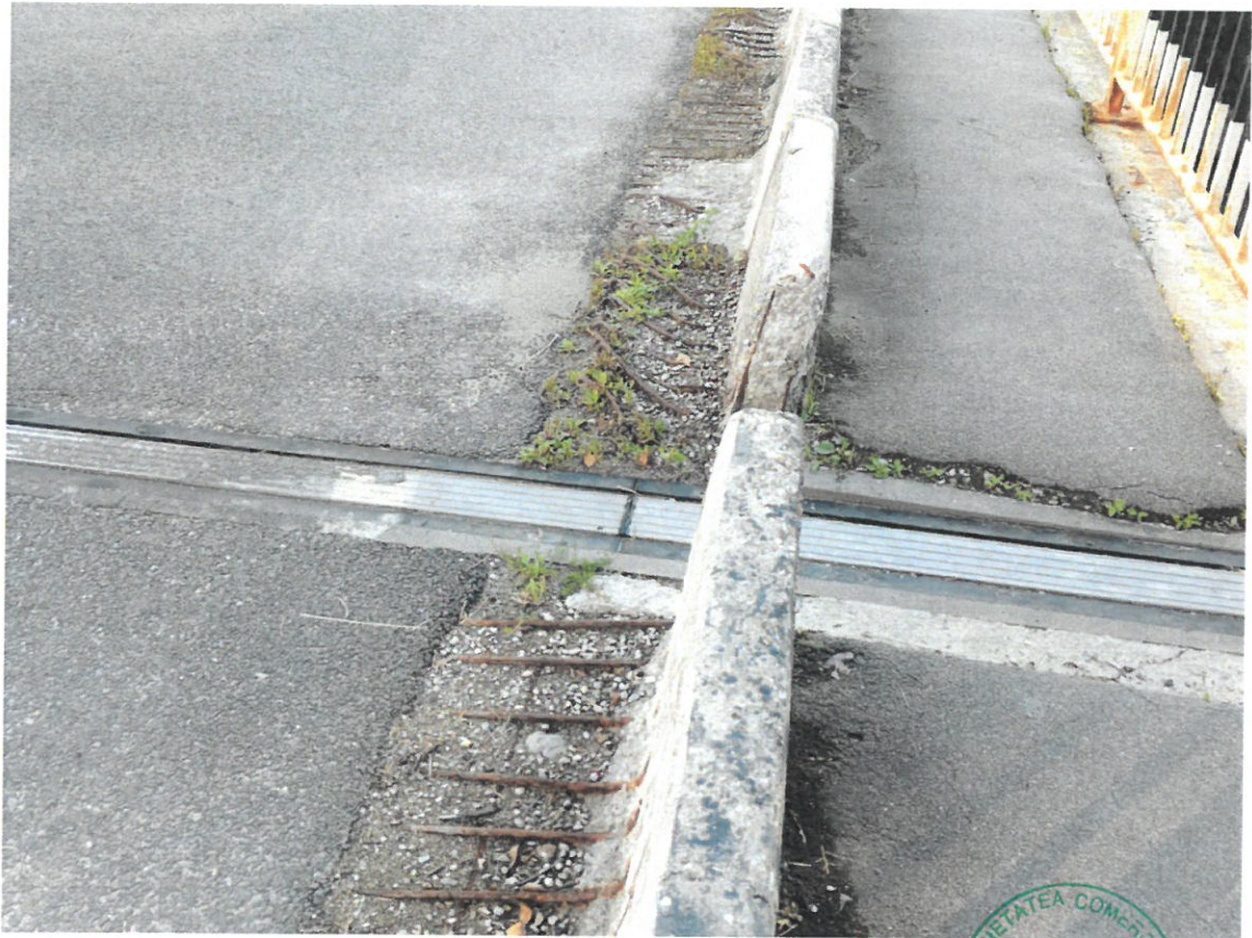
Foto nr. 11 – Degradarea sau dislocarea bordurilor
